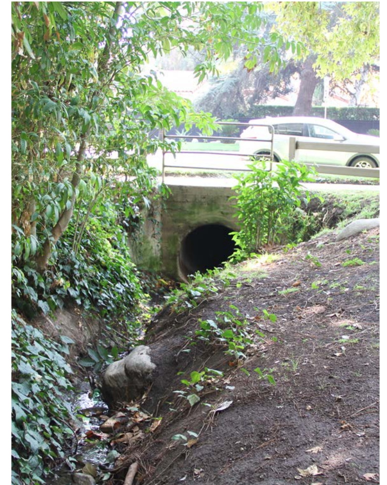
Existing storm drain at Los Feliz Blvd.
