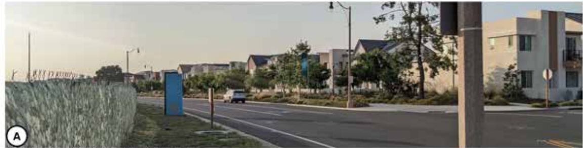
A. Residential edge condition, northern edge
